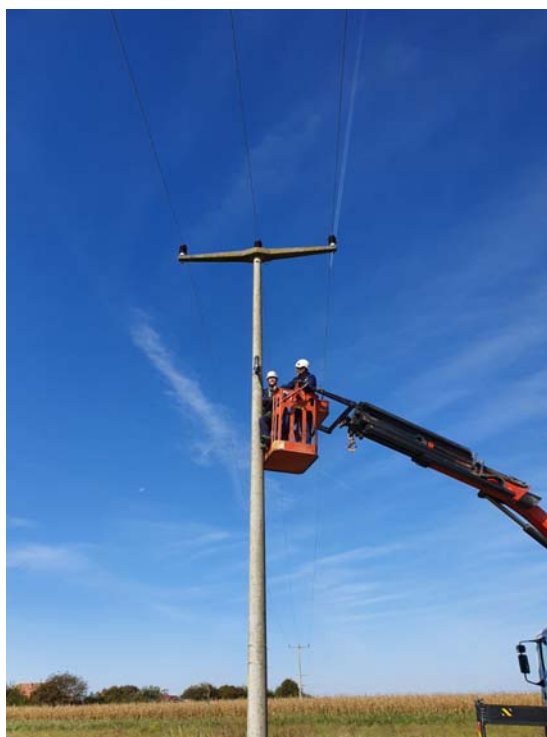
Slika 6. Ugradnja indikatora na betonski stup
